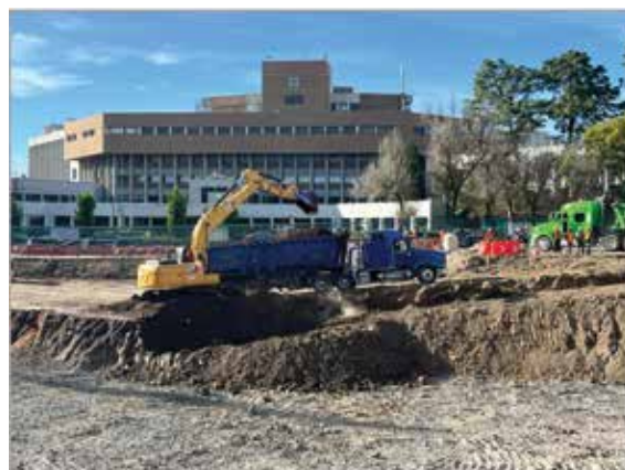
Excavación en el Estacionamiento Norte para la construcción de la UAEPE. Diciembre 2023.
